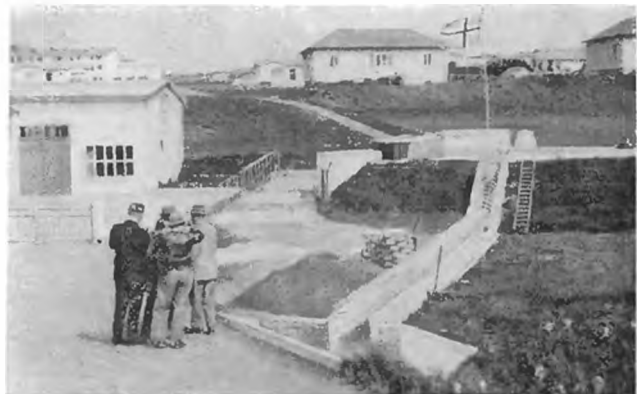
Рис. 4. Центральный коллектор отопительной системы и главная насосная станция
