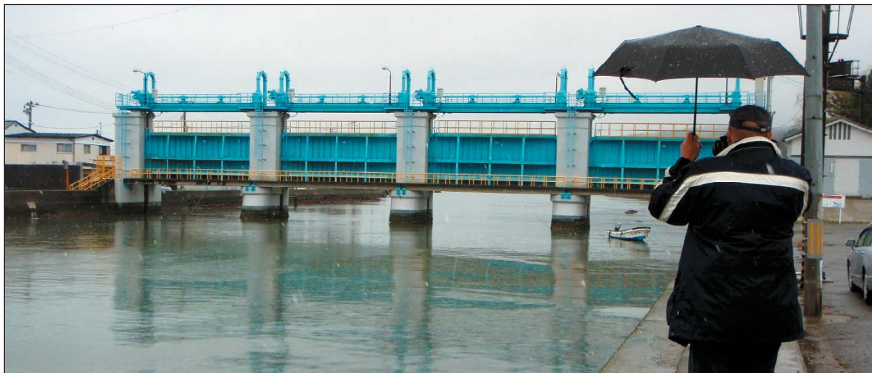
Рис.5. Цунамизащитные ворота и дамба в г.Минами-Санрику.
