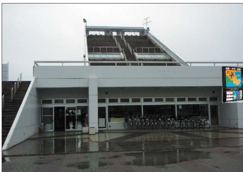
Рис.6. Места эвакуации во время цунами, обустроенные на крышах зданий. В ряде случаев их высота оказалась недостаточной.
