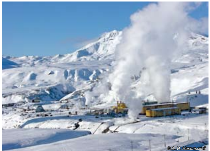
2. Мутновская геотермальная электростанция
