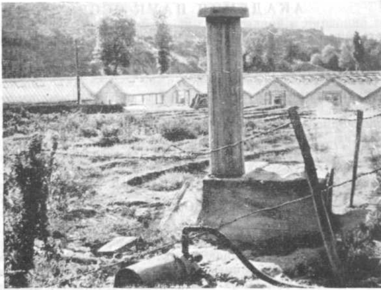
Рис. 1. Использование горячих вод для отопления оранжерей и теплиц в Сапански на краю массива Пирин
