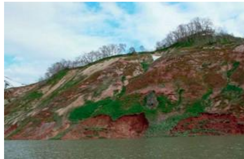
Рис. 1. Оползни на левом берегу подпрудного озера
